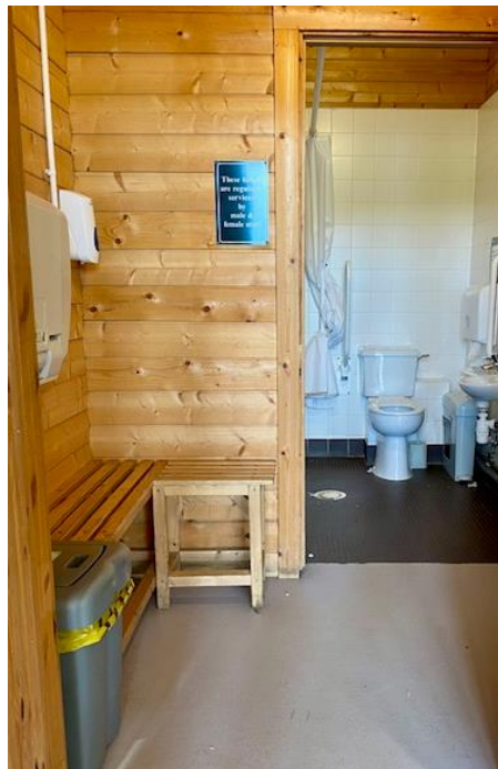
Inside accessible toilet
